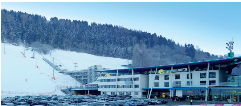
Talstation Planai, Schladming / Österreich - Fotos: Paul Ott, Graz
