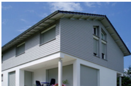
Einfamilienhaus in Deutschland, Stülpschalung, Cedral grau CS 205
