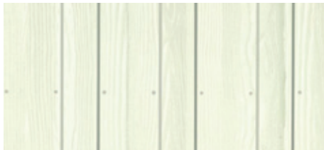
vertikale Boden-Deckel-Schalung (Sturzschalung)
