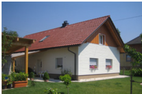
Einfamilienhaus in Österreich, Stülpschalung Cedral weiß CS 107 und Boden-Deckel-Schalung am Giebel mit Cedral orange CS 732
