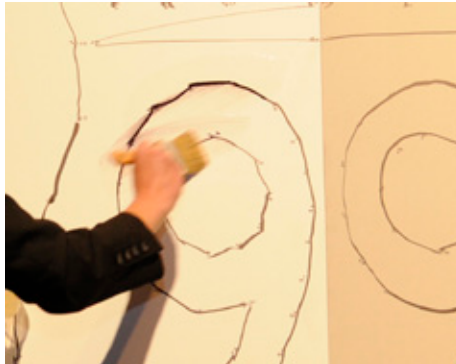
Das Graffiti wird mit dem Graffiti-Entferner großzügig eingepinselt.
