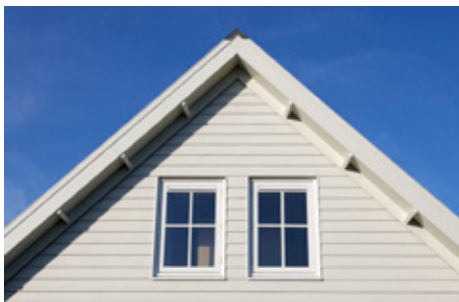
Giebel eines Einfamilienhauses in Belgien, Stülpschalung
